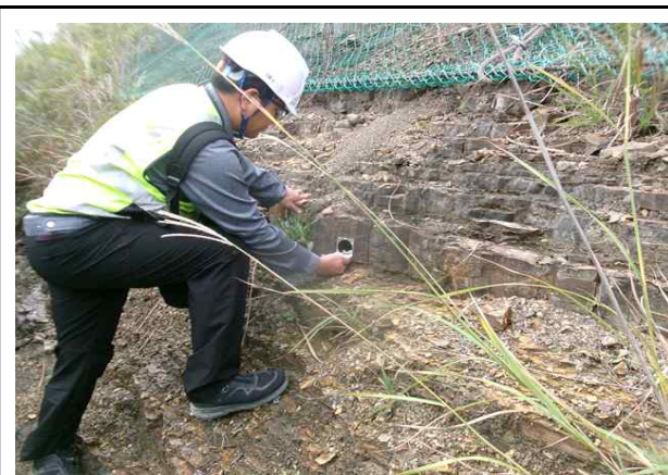
절리면 경사/경사방향 측정
